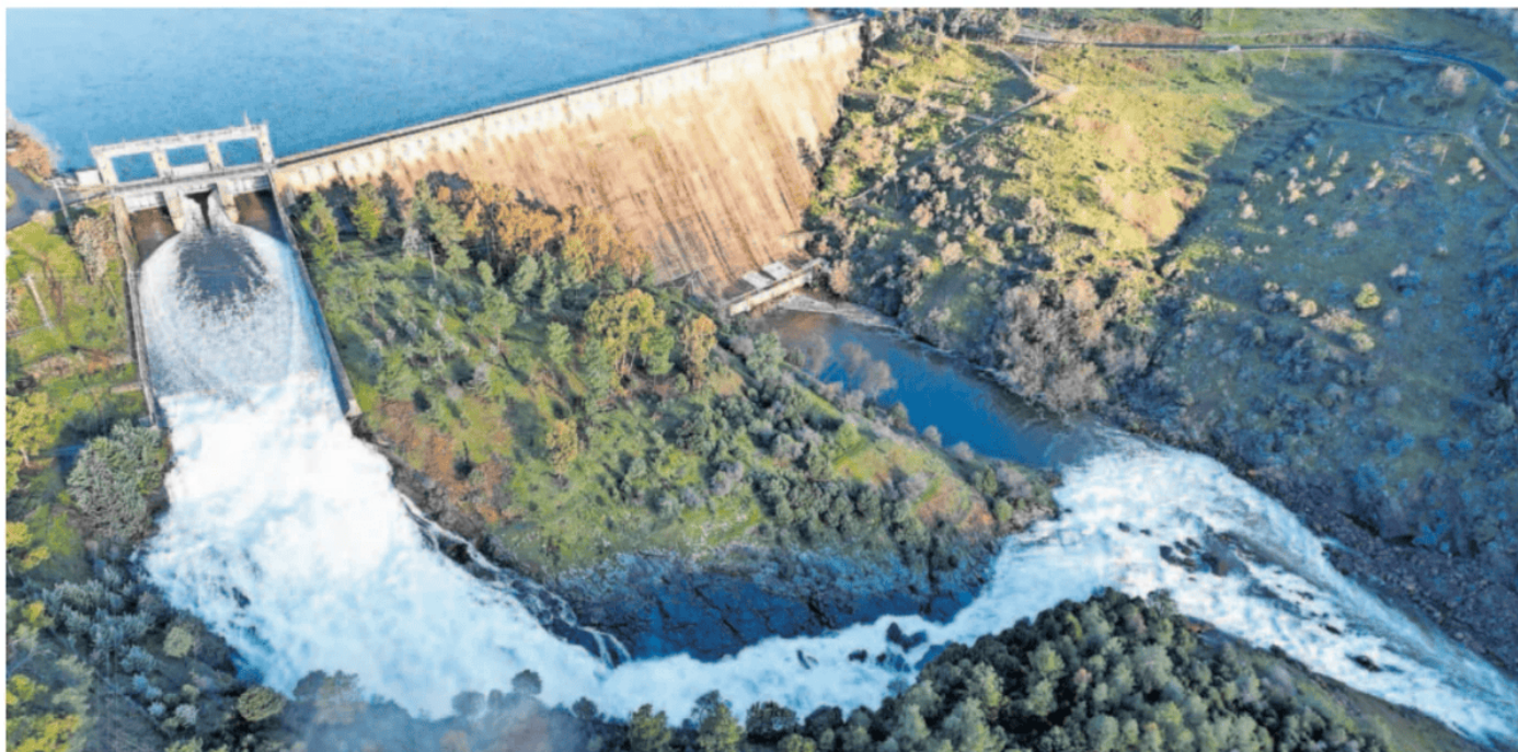
Presa del Burguillo, en Ávila, con las compuertas abiertas para desembalsar agua, en una imagen de la Confederación Hidrográfica del Tajo.
