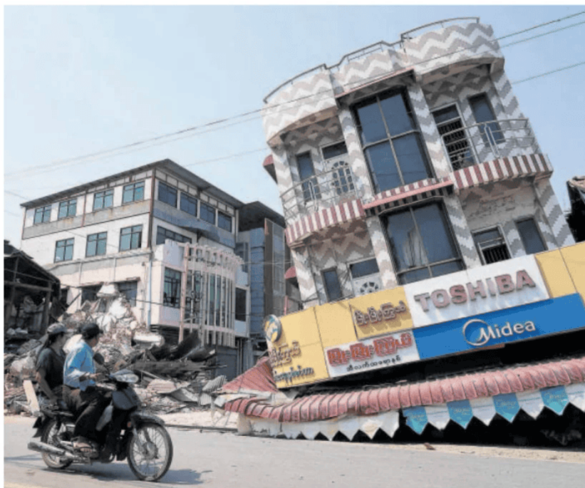
Un edificio dañado por el sismo en la ciudad birmana de Naypyitaw, ayer. AUNG SHINE OO (AP/LAPRESSE)
